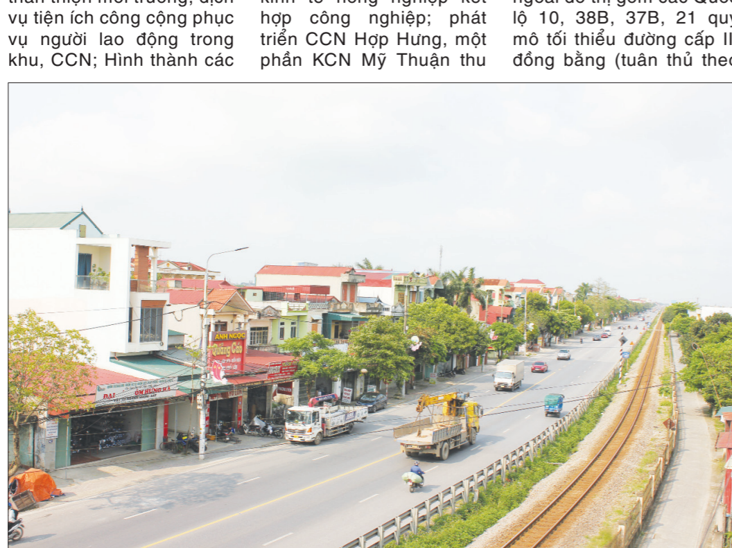
Quốc lộ 10 và tuyến đường sắt Bắc - Nam đoạn qua thị trấn Gôi (Vụ Bản).
