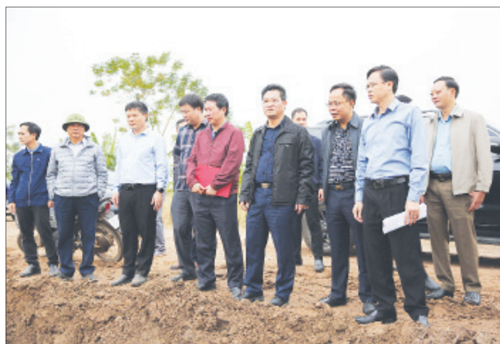
Đồng chí Trần Anh Dũng, Ủy viên Ban TVTU, Phó Chủ tịch Thường trực UBND tỉnh kiểm tra tiến độ thi công dự án tuyến đê, kè biển tại xã Phúc Thắng (Nghĩa Hưng).
