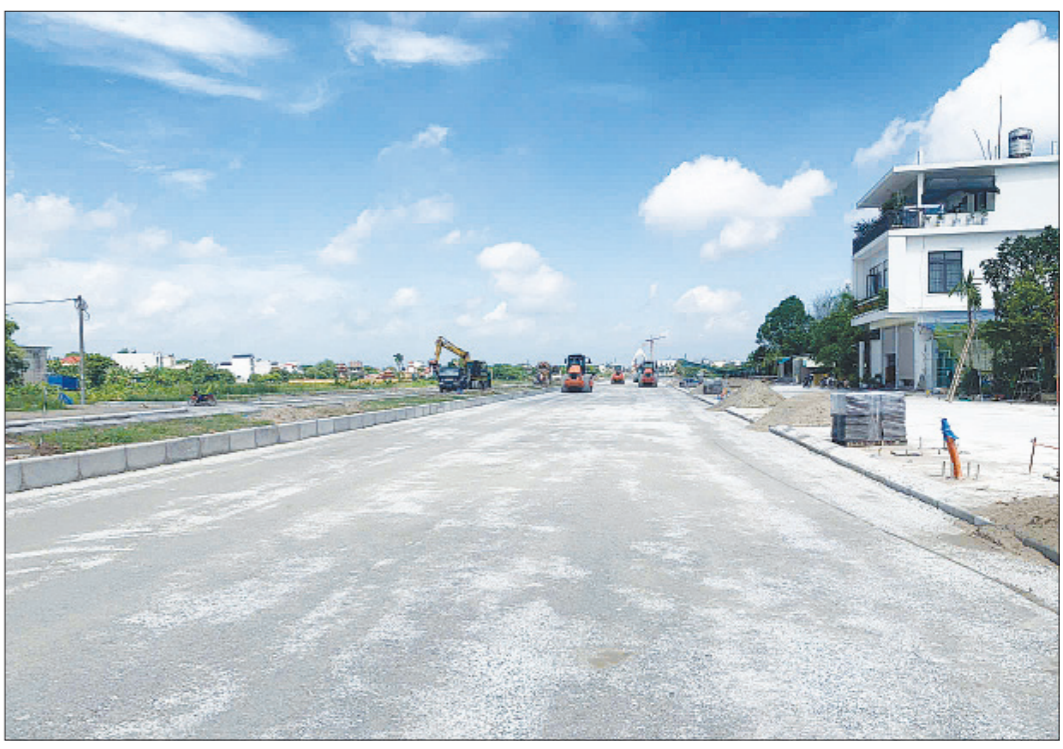
Thi công công trình đường trục phía Nam thành phố Nam Định.
