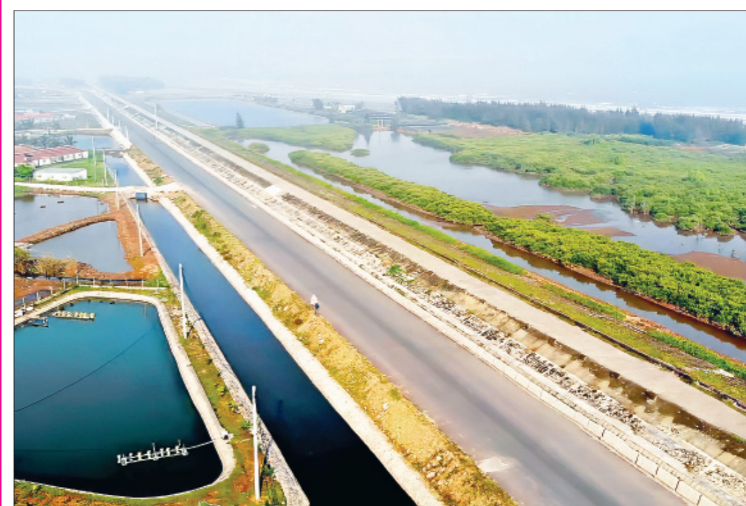
Dự án tuyến đường bộ ven biển dài 65,58km, đoạn qua tỉnh Nam Định có tổng mức đầu tư gần 2.700 tỉ đồng đang hoàn thiện các hạng mục cuối cùng và dự kiến thông xe vào dịp 30-4-2024.
