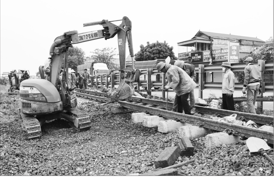
Công nhân Công ty Cổ phần Đường sắt Hà Ninh sửa chữa đường ray trên tuyến đường sắt Bắc - Nam.
