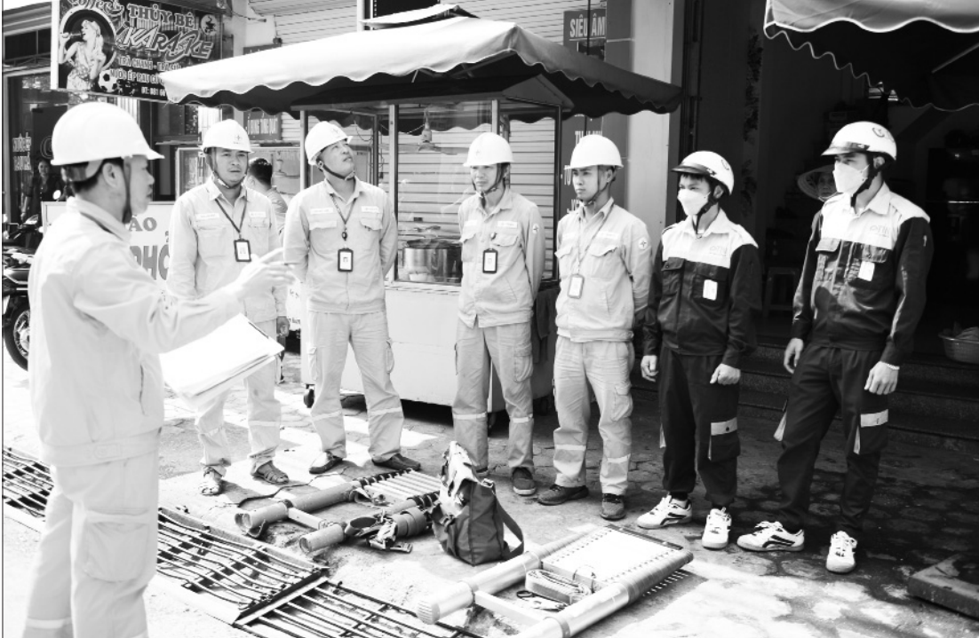
Đội lực huyện Giao Thủy triển khai nhiệm vụ sửa chữa lưới điện.
