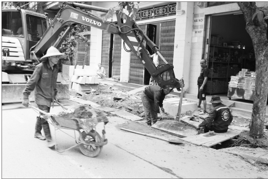
Cải tạo, nâng cấp hệ thống cống thoát nước và vỉa hè tuyến đường Minh Khai để tăng năng lực thoát nước đô thị.
