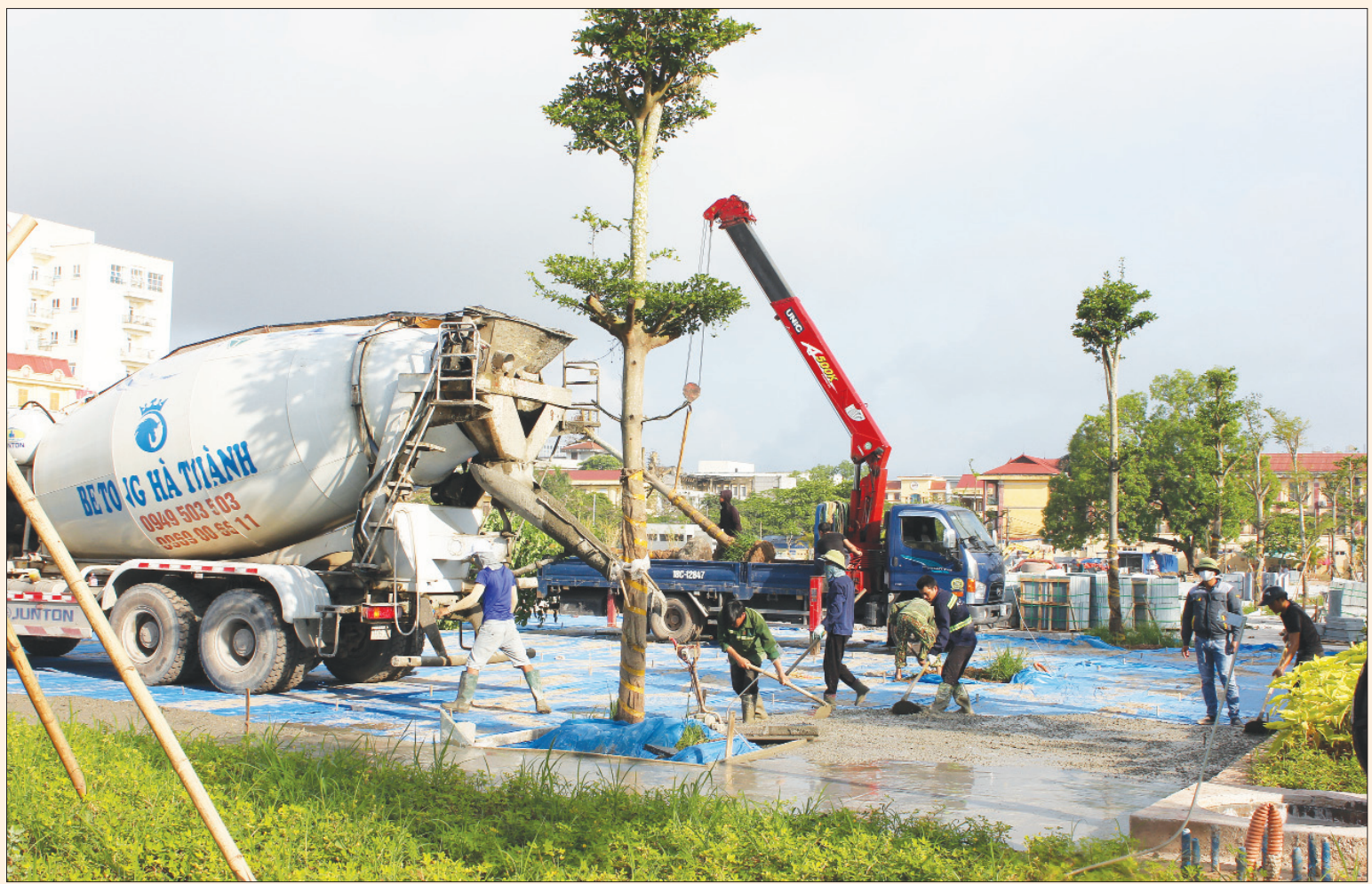
Thi công công trình tạo quảng trường Hòa Bình tạo điểm nhấn cảnh quan, kiến trúc cho khu vực trung tâm thành phố Nam Định.
