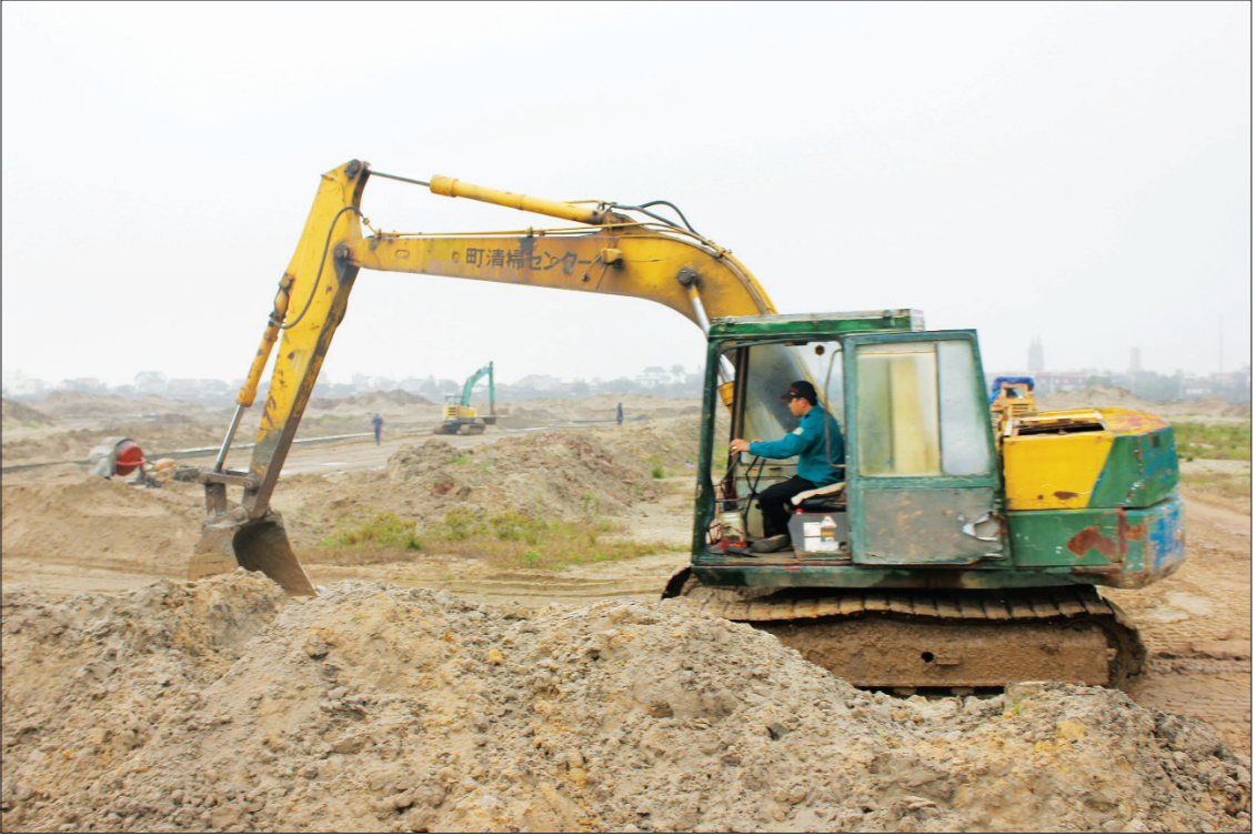
Thi công các hạng mục Dự án đầu tư xây dựng khu dân cư tập trung thị trấn Quý Nhất (Nghĩa Hưng).
