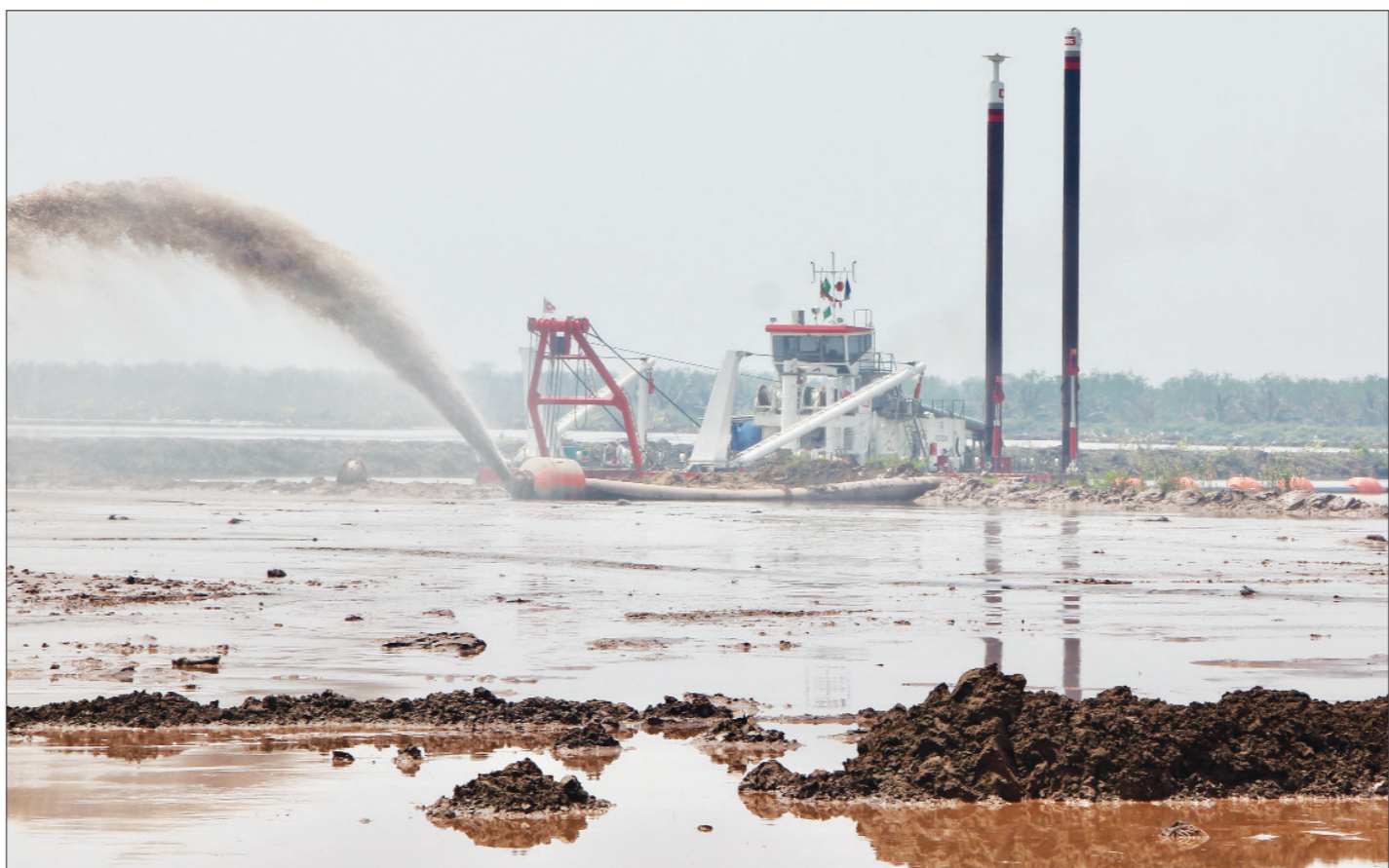
Thi công san lấp mặt bằng để xây dựng dự án đầu tiên trong chuỗi dự án quy mô lớn của Tập đoàn Xuân Thiện tại Cồn Xanh.
