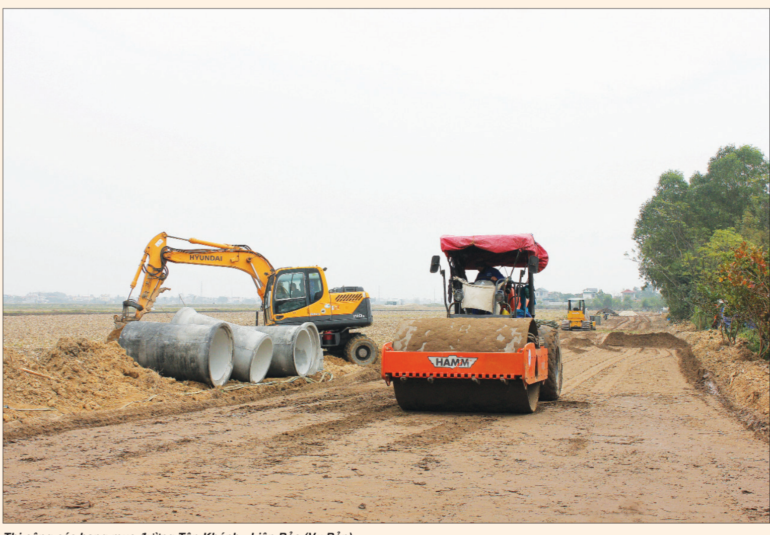
Thi công các hạng mục đường Tân Khánh - Liên Bảo (Vụ Bản).
