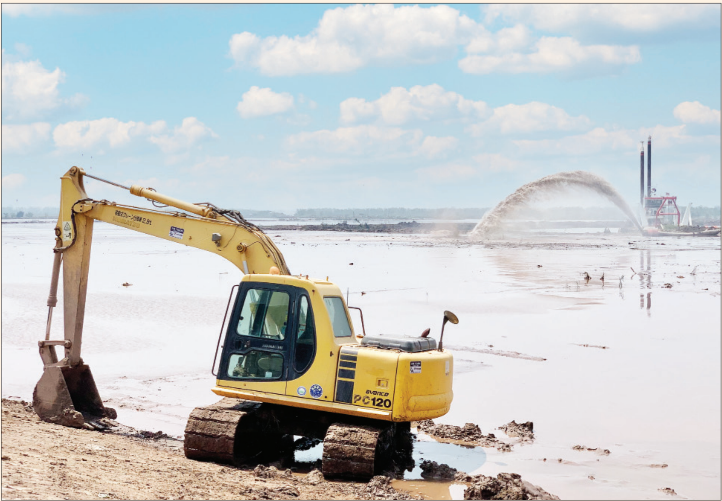
Được tạo điều kiện thuận lợi, Tập đoàn Xuân Thiện bước đầu triển khai san lấp mặt bằng dự án đầu tiên trong chuỗi dự án quy mô lớn tại Cồn Xanh (Nghĩa Hưng).
