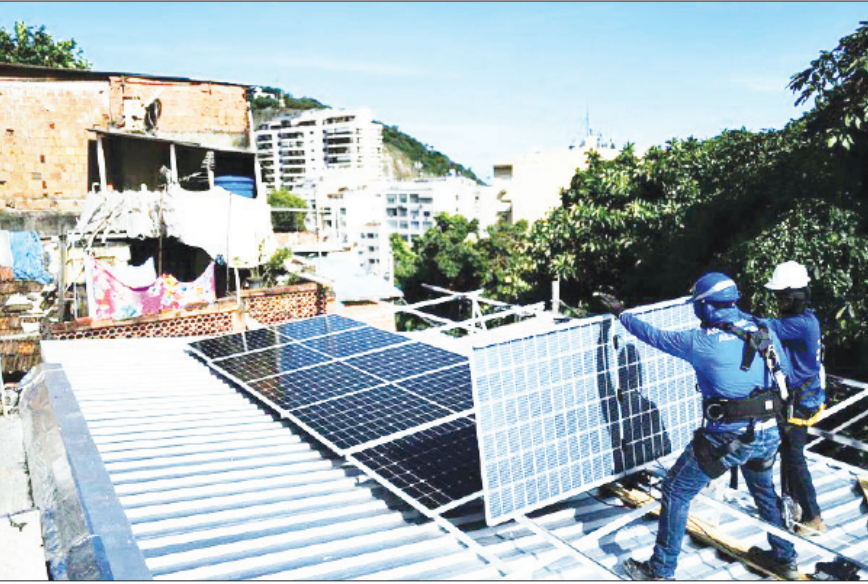
Lắp đặt tấm pin mặt trời tại thành phố Rio de Janeiro, Brazil.
