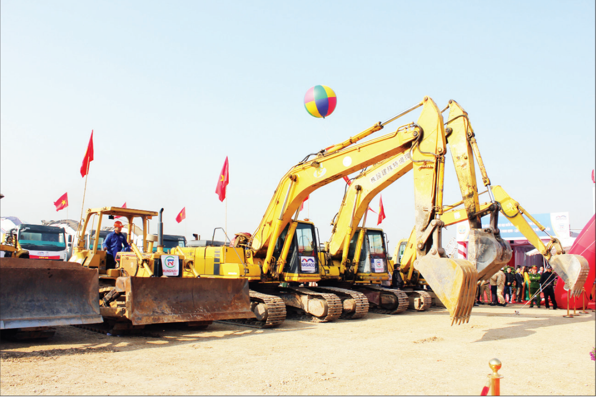
Khởi công dự án đầu tư xây dựng tuyến đường bộ mới Nam Định - Lạc Quấn - đường bộ ven biển tháng 12-2022.
