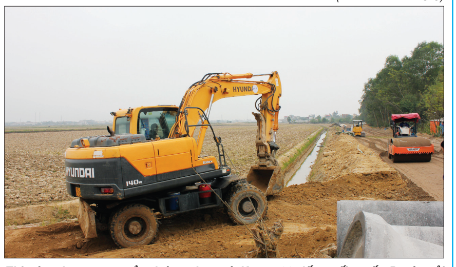
Thi công hạng mục nền đường đoạn từ Km7+500 đến cuối tuyến Dự án cải tạo, nâng cấp tuyến đường Tân Khánh - Liên Bảo trên địa phận huyện Vụ Bản.
