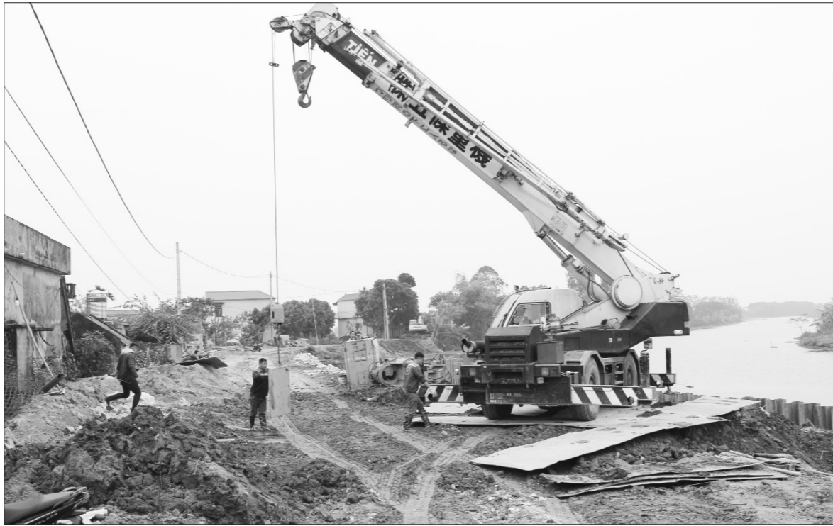
Thi công hạng mục kè sông Sắt, dự án cải tạo, nâng cấp đường Tân Khánh - Liên Bảo thuộc địa phận xã Tân Khánh.
